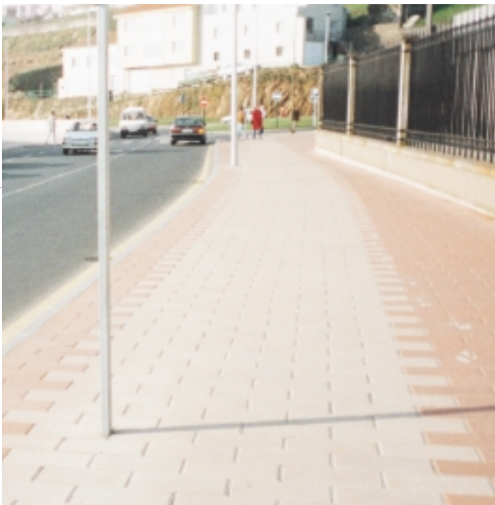
Paseo peatonal, Valladolid
